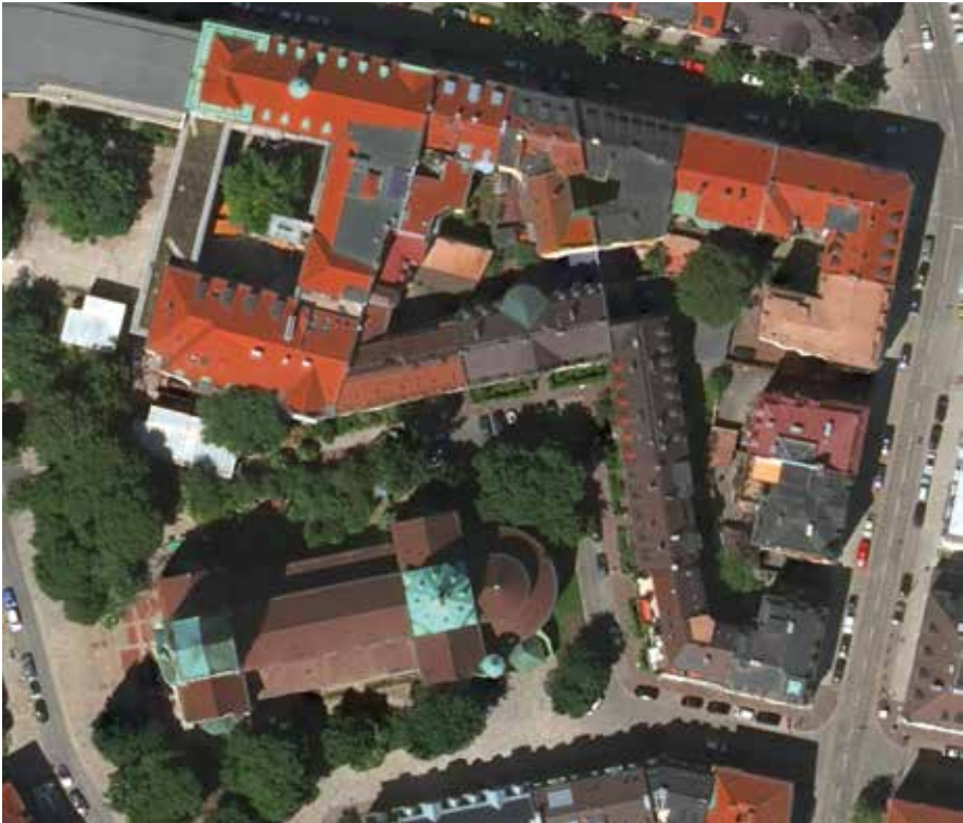
Abb. 4: TrueOP des Bereiches um die Kirche St. Anna ohne Gebäudefassaden, München, Lehel
