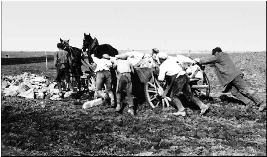
Bild 4: Wegebau in Baldersheim 1930
