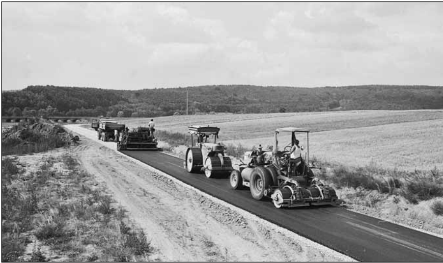
Bild 5: Wegebau in Aschach in den 70er Jahren
