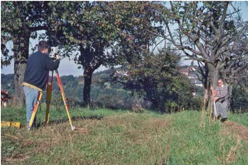
Bild 9: Vermessungsarbeiten in Oberafferbach
