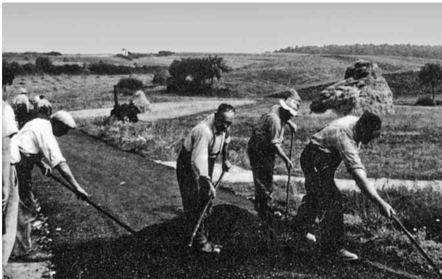
Bild 6: Wegebau in Aschach in den 70er Jahren
