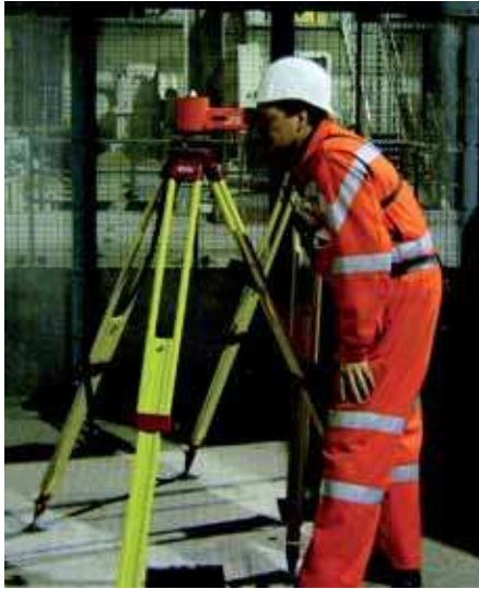
Bild 3: Nadirlot am Schachtkopf
