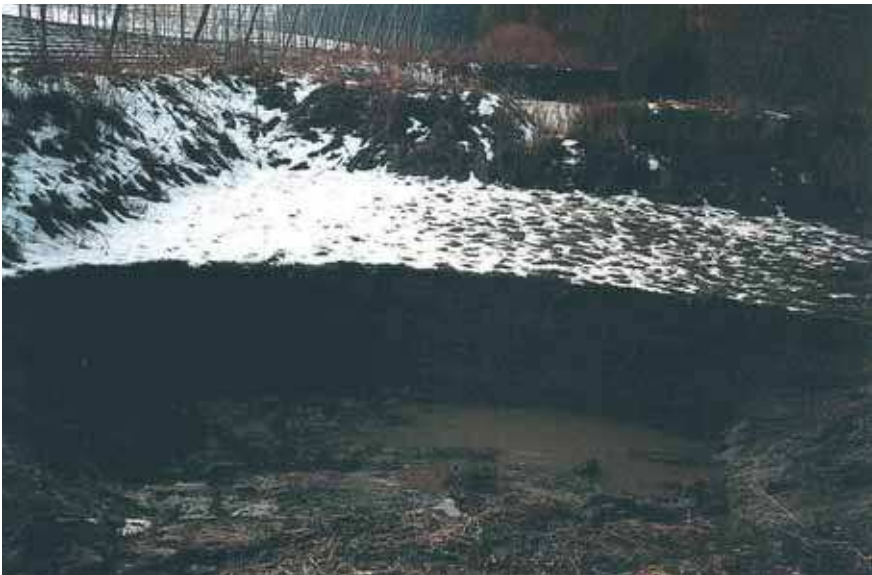
Bild 11: Abgesetzter, erodierter Boden in einem halb geräumten Erdbecken im Flurneuordnungsgebiet Obermettenbach, Landkreis Pfaffenhofen a. d. Ilm (Foto: Alexander Lukas)
