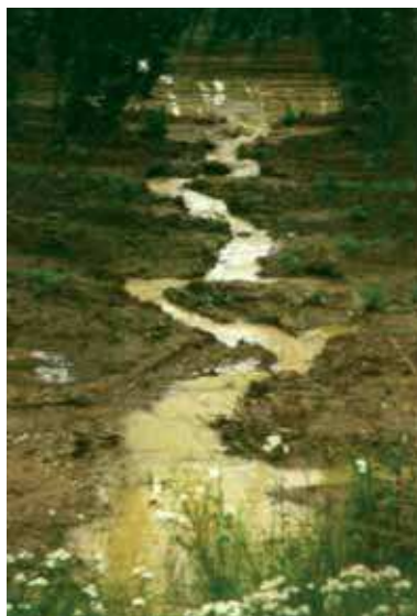
Bild 3: Regen hat die quer zum Hang gearbeiteten Bifänge durchweicht und durchbrochen
