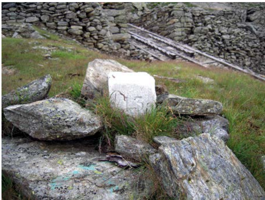
Abbildung 7: TP mit einem Stein aus weißem Marmor, dahinter Teil einer ehemaligen Erzaufzugseinrichtung (14-Nothelfer-Bremsberg). Foto: Marcus Wandering
