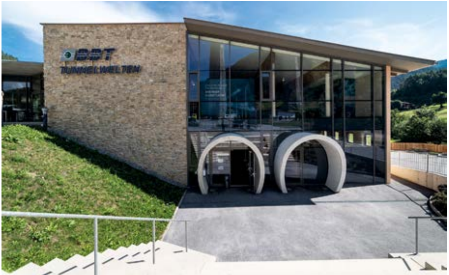
Abbildung 1: Der Eingangsbereich des Informationszentrums „Tunnelwelten“ des Brenner-Basistunnels erinnert an zwei Tunnelröhren. Foto: BBT-SE
