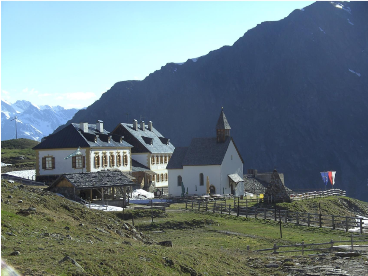
Abbildung 1: Ehemaliges Direktionsgebäude des k. k. Bergwerks am Schneeberg, heute Schneeberghütte. Foto: Dr. Franz R. Schlosser
